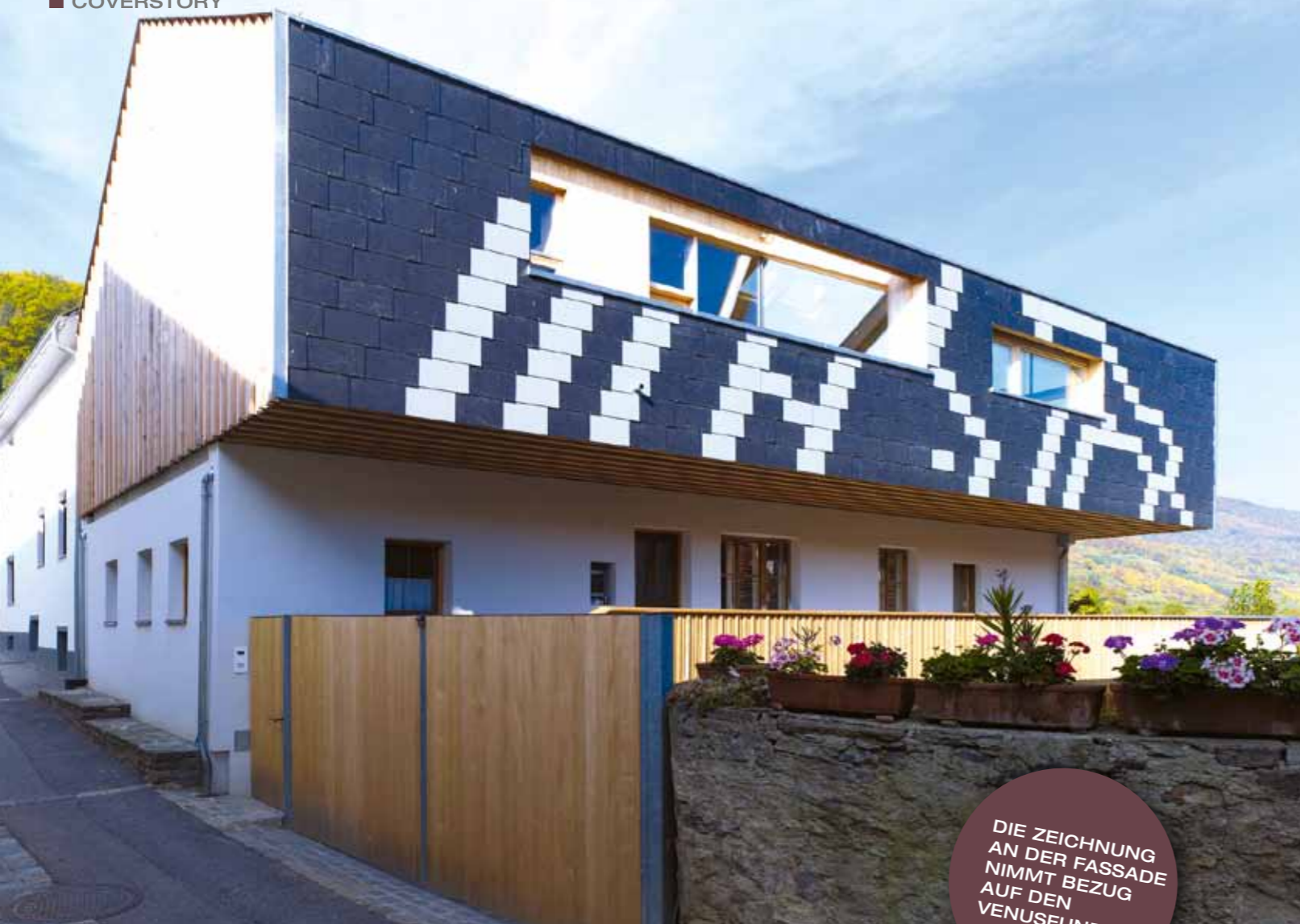
DAS SCHIEFERARTIGE DACH AUS KLEINTEILIGEN FASERZEMENT-PLATTEN ZIEHT SICH IM OSTEN ÜBER DIE WAND
